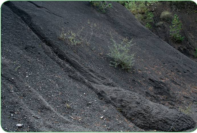
Figure 1.2. Érosion sous forme de microglissement.
