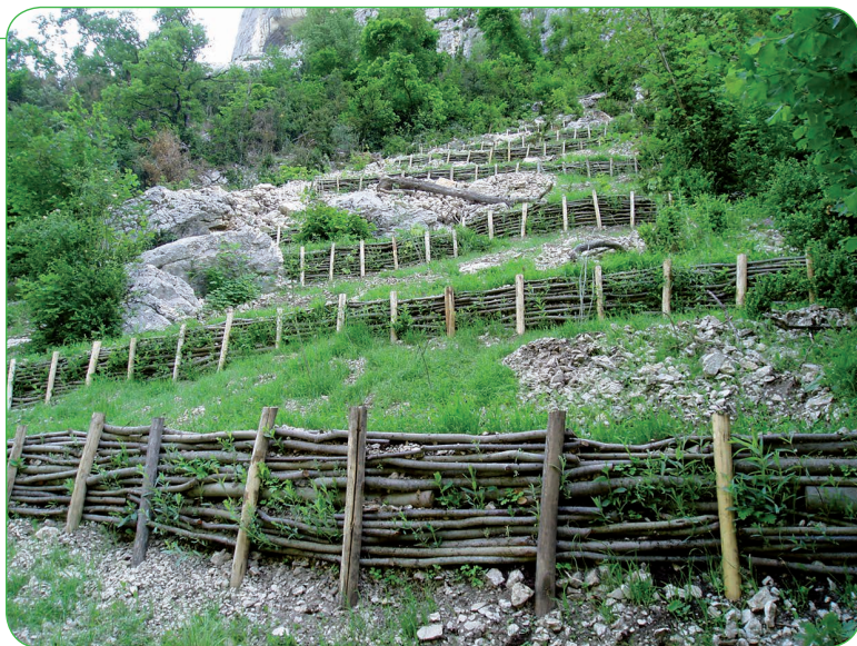
Figure 3. Ouvrages de génie végétal en milieu terrestre.
