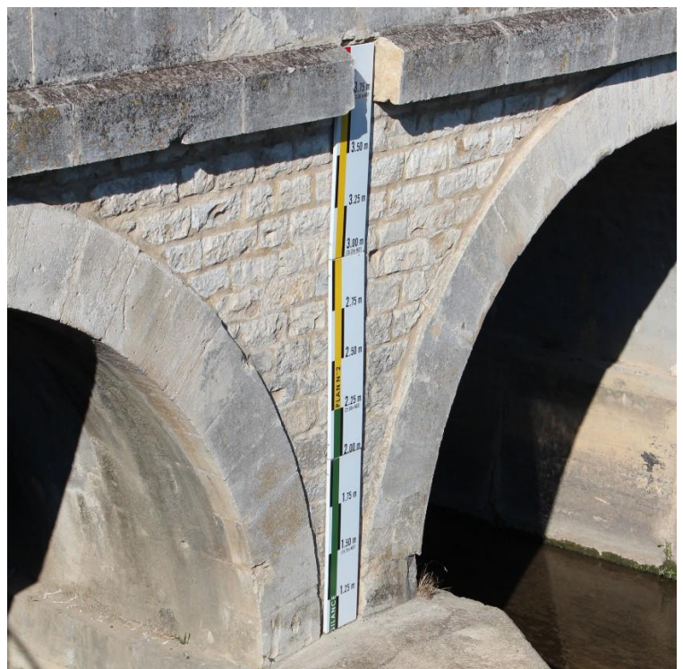
Exemple d'échelle limnimétrique rattachée au PCS communal (crédit photo : SPCGD)
