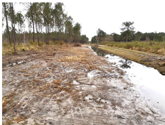
Figure 33 : Écrasement des berges d'un fossé sur une zone humide de plateau du Médoc (Gironde).
